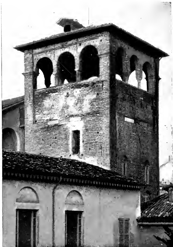
Fig. 355 — Torre del Monastero Maggiore a Milano (a. 568-551)
